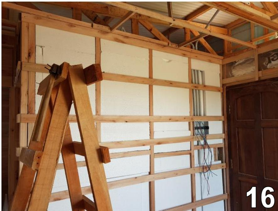
16) Instalación de planchas de telgopor para aislación acústica en habitaciones
