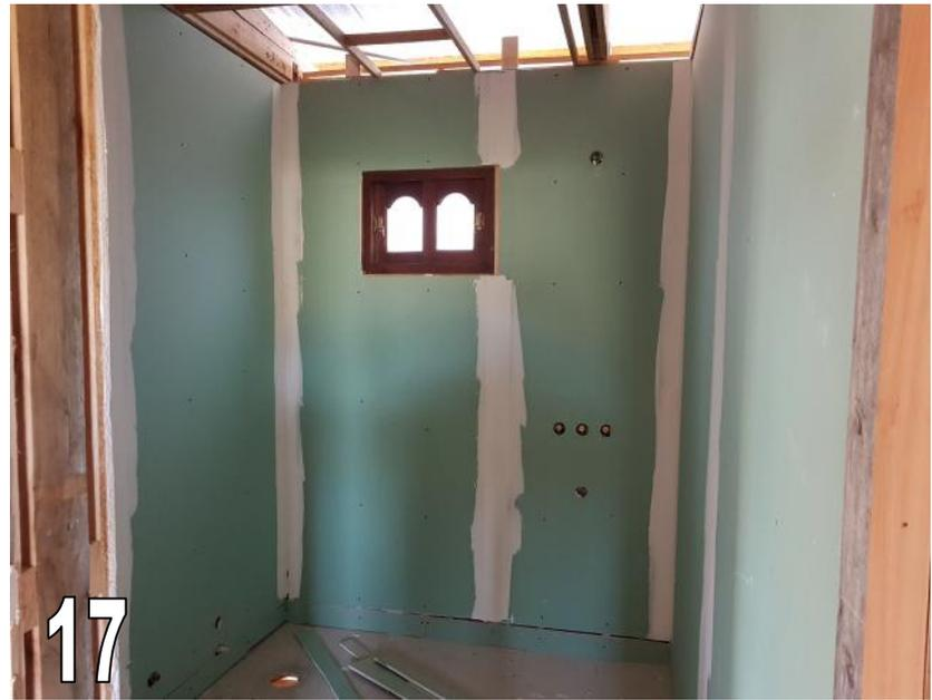
17) Revestimiento interno con machimbre de ½" y placas de yeso anti humeado en baño y cocina.
