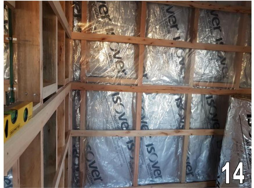
14) Refuerzos de tablas 1x3 cepilladas colocados para la instalación de agua y electricidad. Sobre esta se coloca una varilla adicional para posteriormente instalar el revestimiento final.
